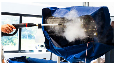
PULIZIA E SANIFICAZIONE A VAPORE
